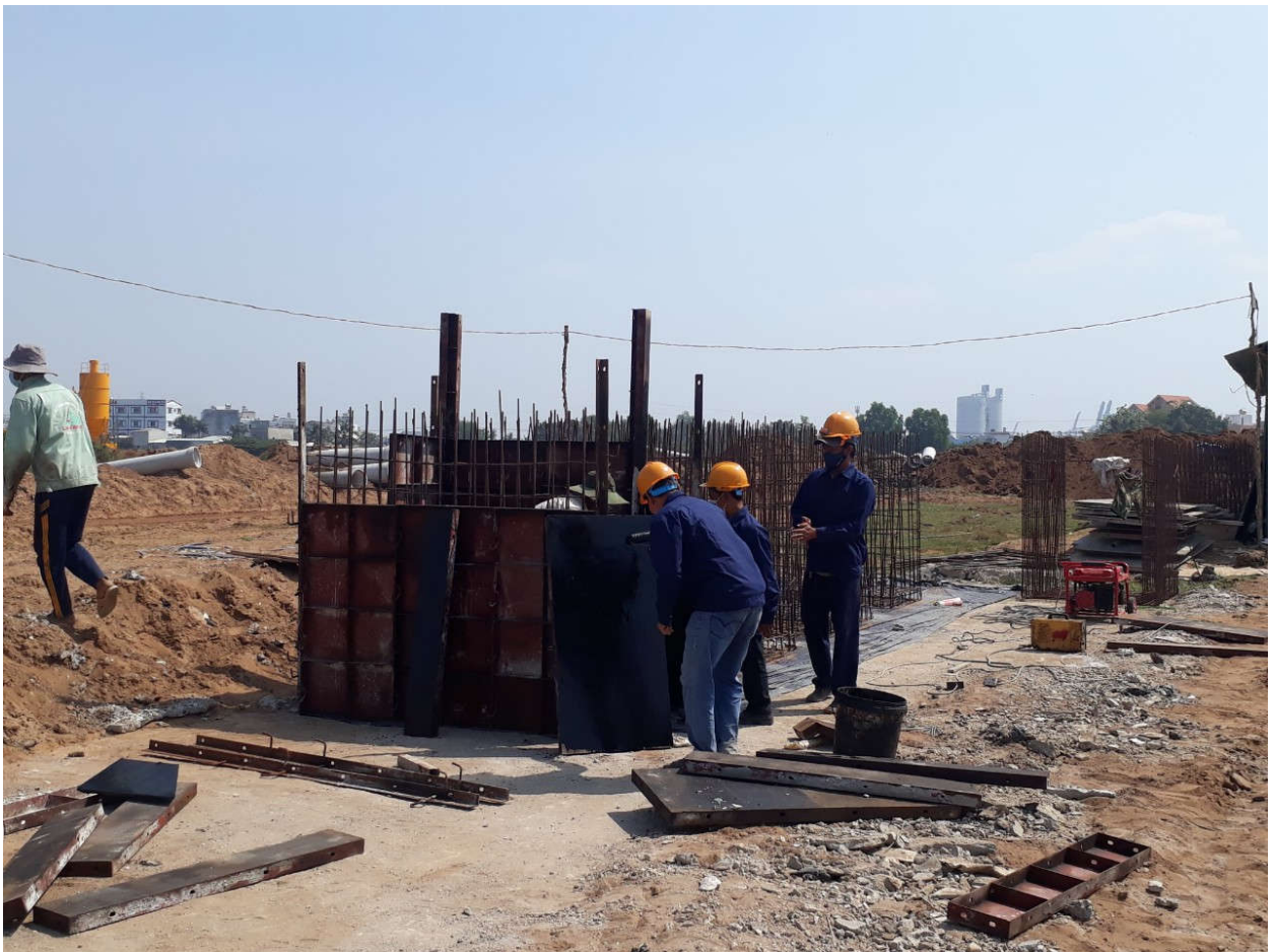
Lắp đặt cốp pha hồ ga
