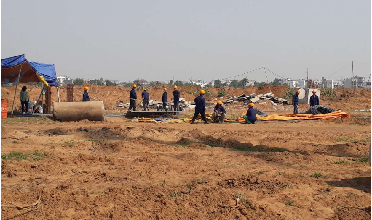
Công nhân gia công thép hồ ga
