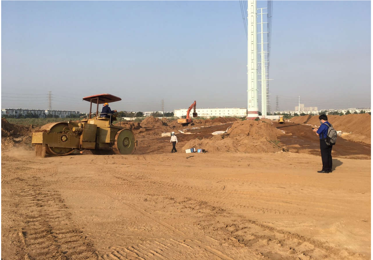
Thi công tuyến đường 15
