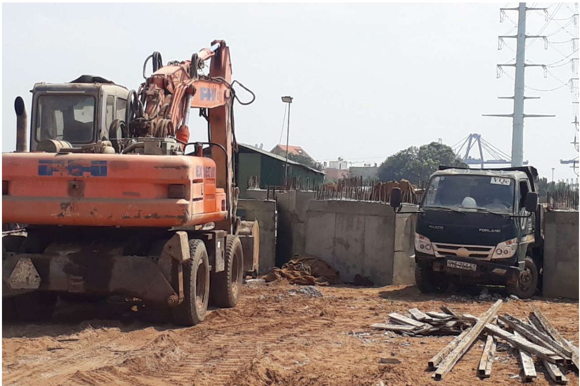
Xe máy trên công trường
