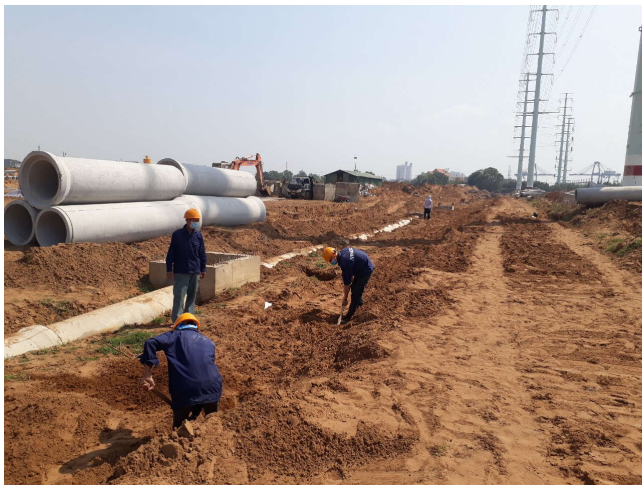
Công nhân làm việc trên công trường
