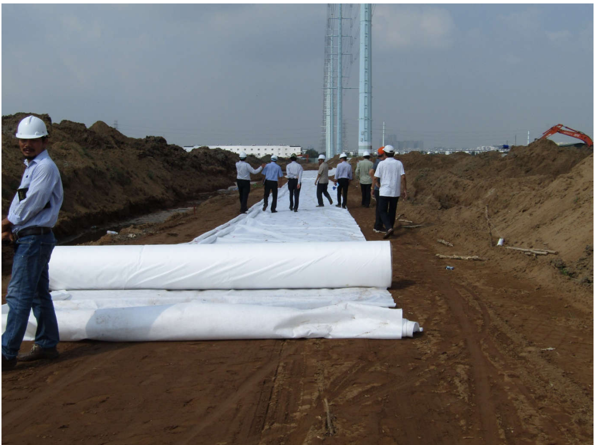
Trải vải địa nền đường
