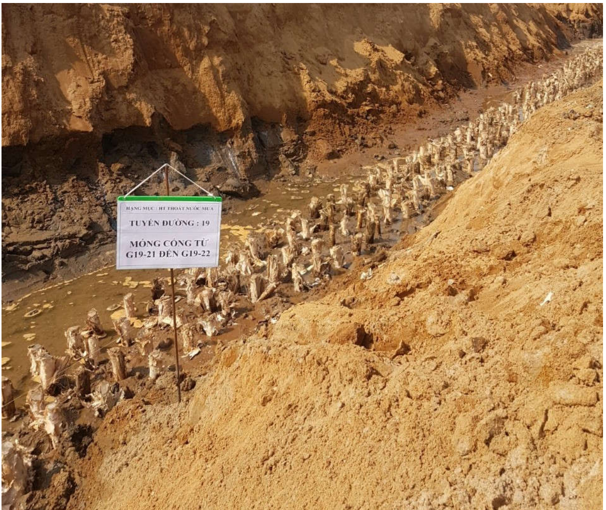
Cừ tràm công băng đường từ G19-21 đến G19-22
