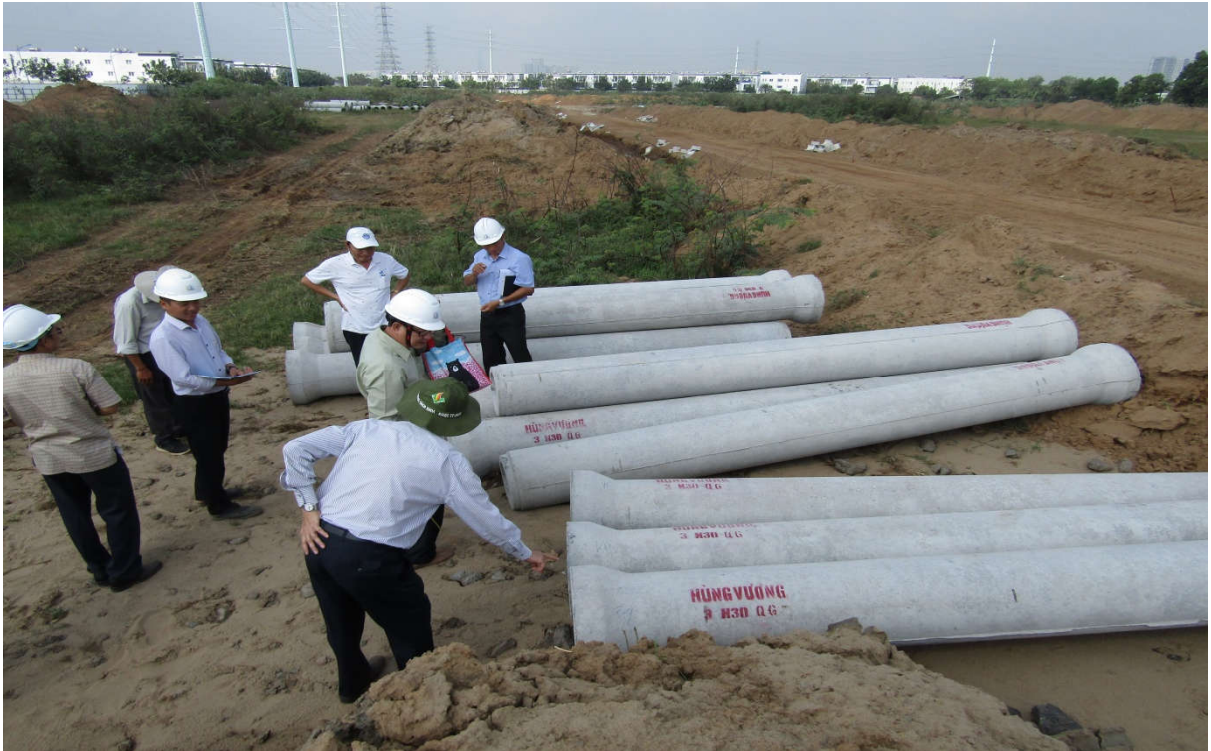
Kiểm tra ống công tại công trường
