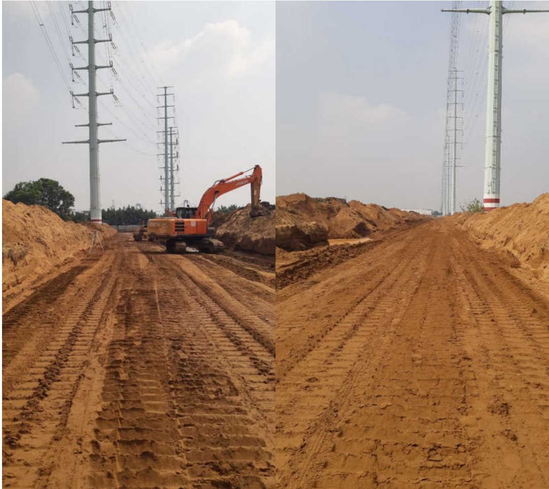
Bóc hữu cơ và đào khuôn đường 15
