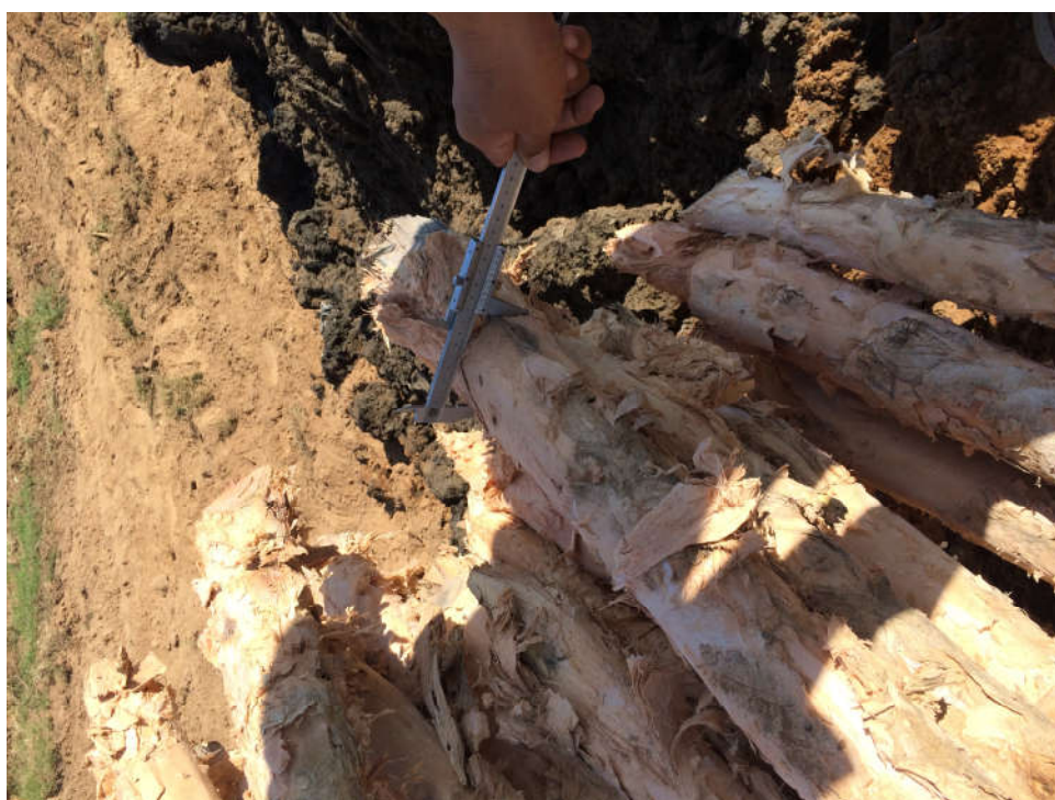
Kiểm tra, nghiệm thu cừ tràm trước khi đưa vào sử dụng
