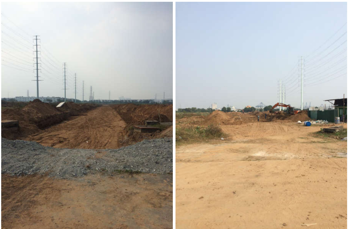
Bóc hữu cơ và đào khuôn đường 16
