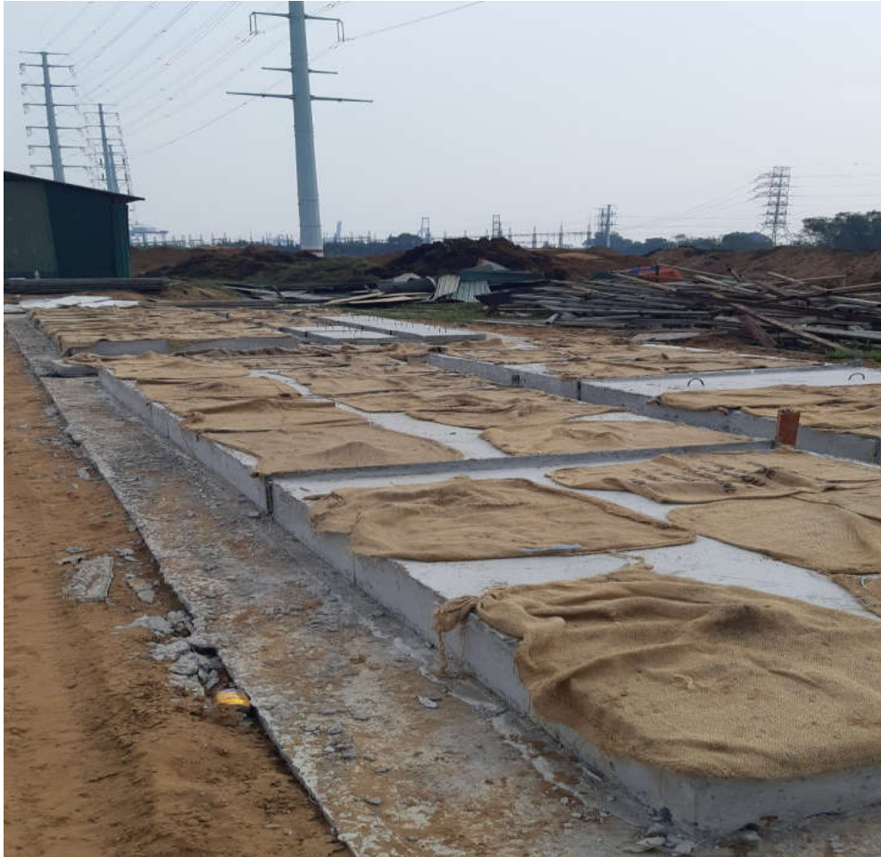
Bảo dưỡng bê tông tấm lót hồ ga
