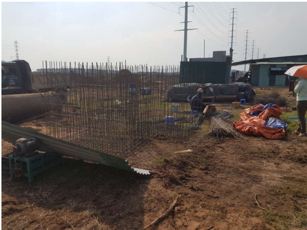
Gia công cốt thép hồ ga
