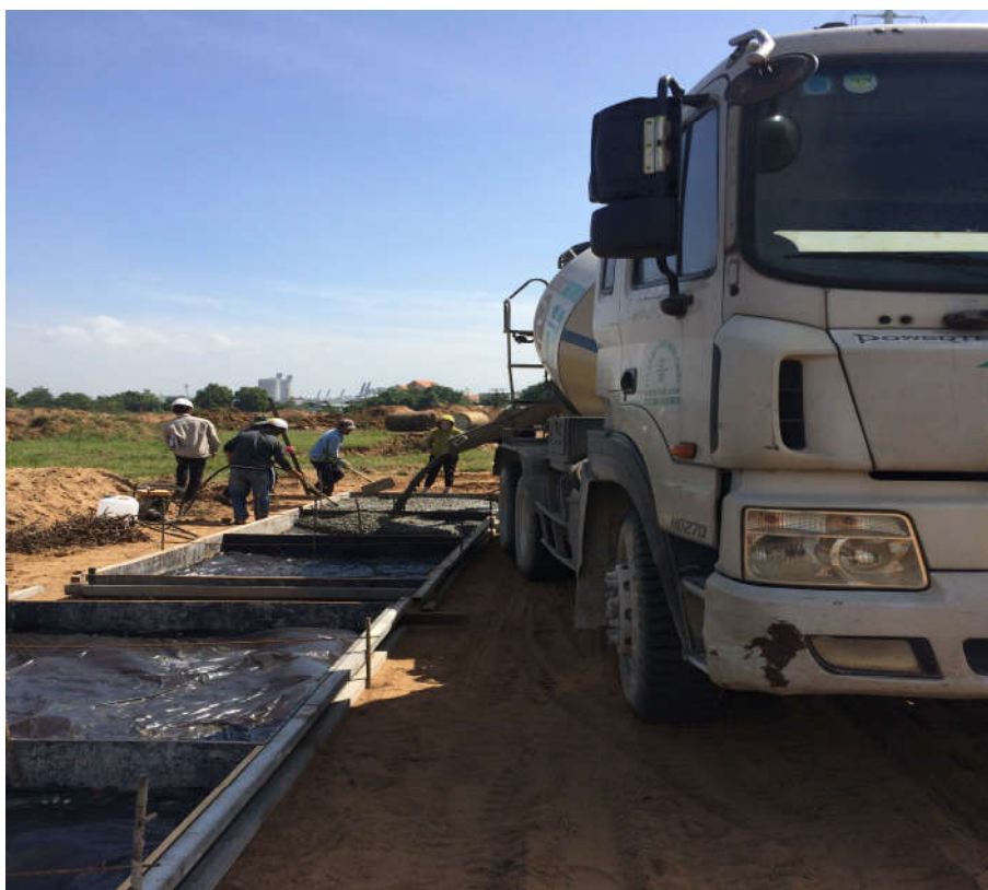
Đổ bê tông tấm lót hồ ga
